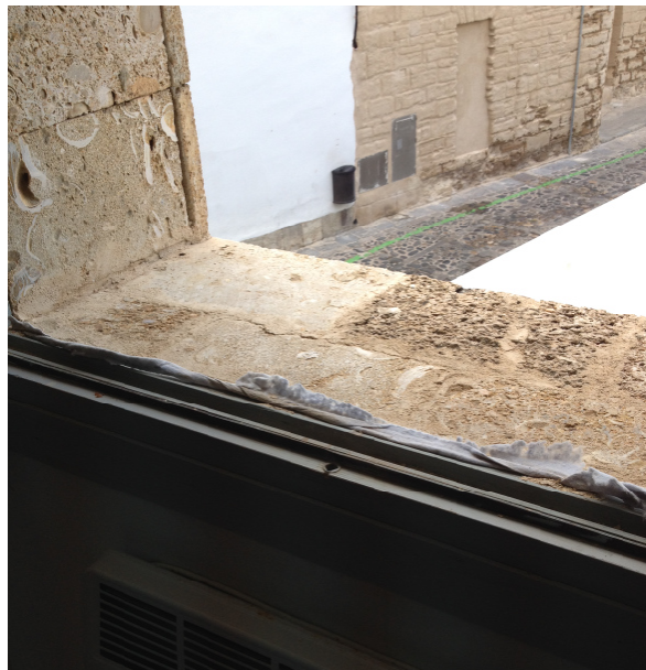
Unión alfeizar con carpintería (ii)
