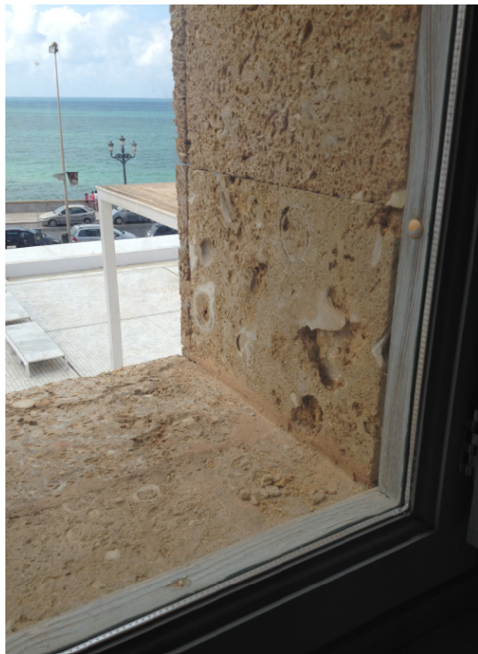
Unión alfeizar con carpintería (i)
