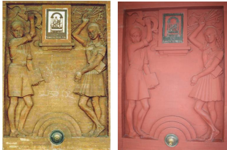
Fig. 3.- Izquierda: Foto de archivo en el que se puede observar el estado original de la obra. Derecha: Estado actual de la fuente tras ser pintada
